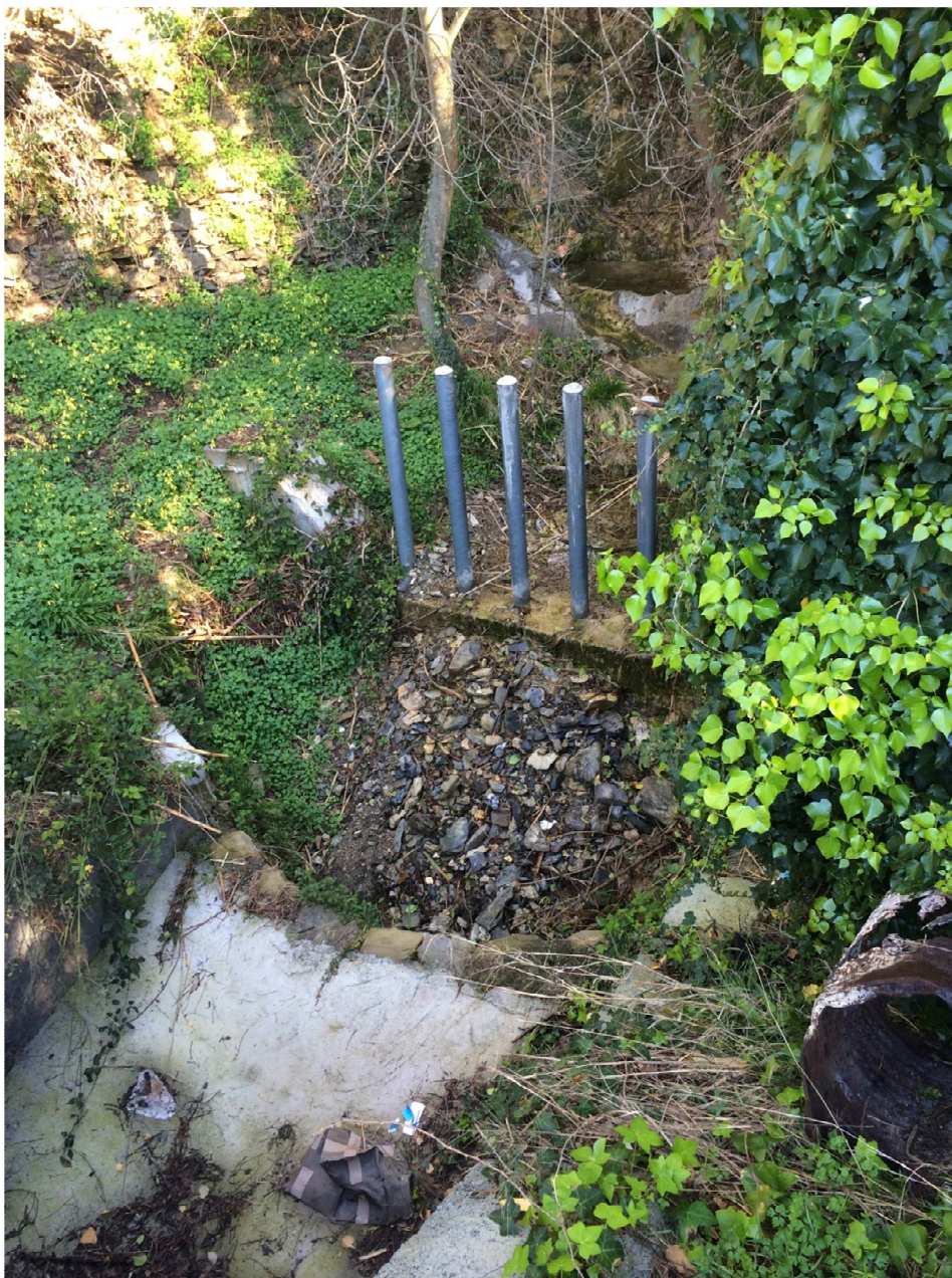
Foto 15 – Sistema di briglia selettiva presente nel tratto iniziale del bacino
