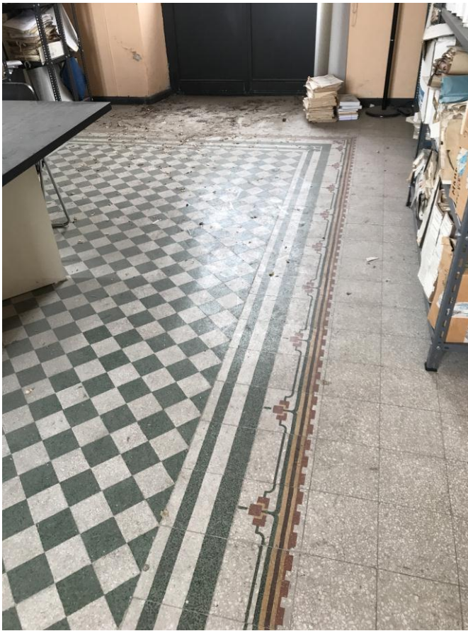
Foto 09 – 10 Il pavimento in "Graniglie" e i serramenti da sostituire
