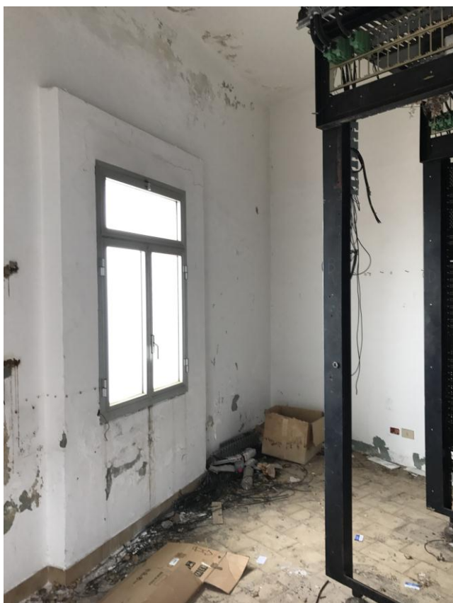
Foto 10-11 I serramenti incongrui da sostituire
